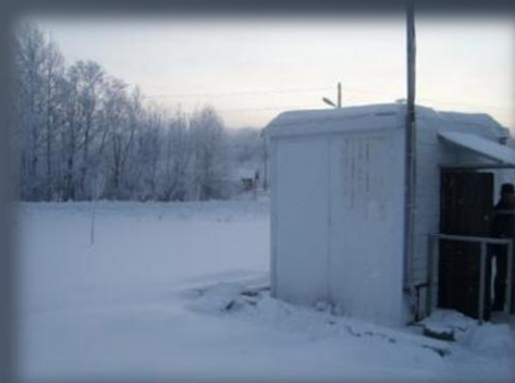
Самотечная и напорная линии водоотведения в н.п. Умба (мощность – 40 м 3 в час)
