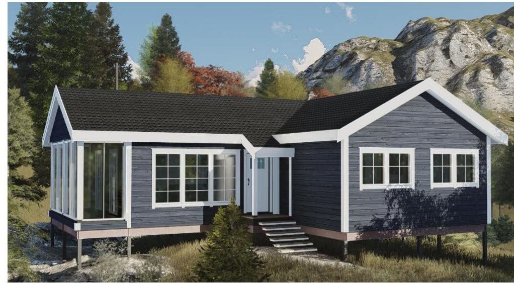
Деревянный каркасный дом по норвежским стандартам. Каркас выполнен из экспортной доски. Утепление стен 200 мм., кровля/перекрытия 300 мм., внутренние перегородки 100 мм. Кровля: металлическая черепица. Фундамент: ленточный из блоков несъемной опалубки.
